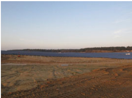
Der 8,5 MW-Solarpark in Lindenhof (Mecklenburg-Vorpommern) wird mit Modulen von Canadian Solar ausgestattet
